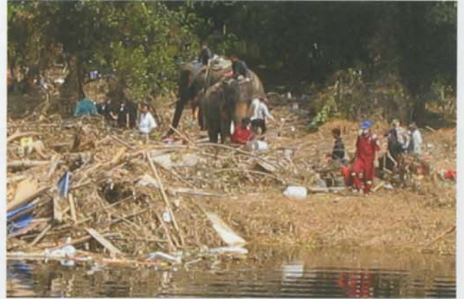
象を使って瓦礫除去作業中
